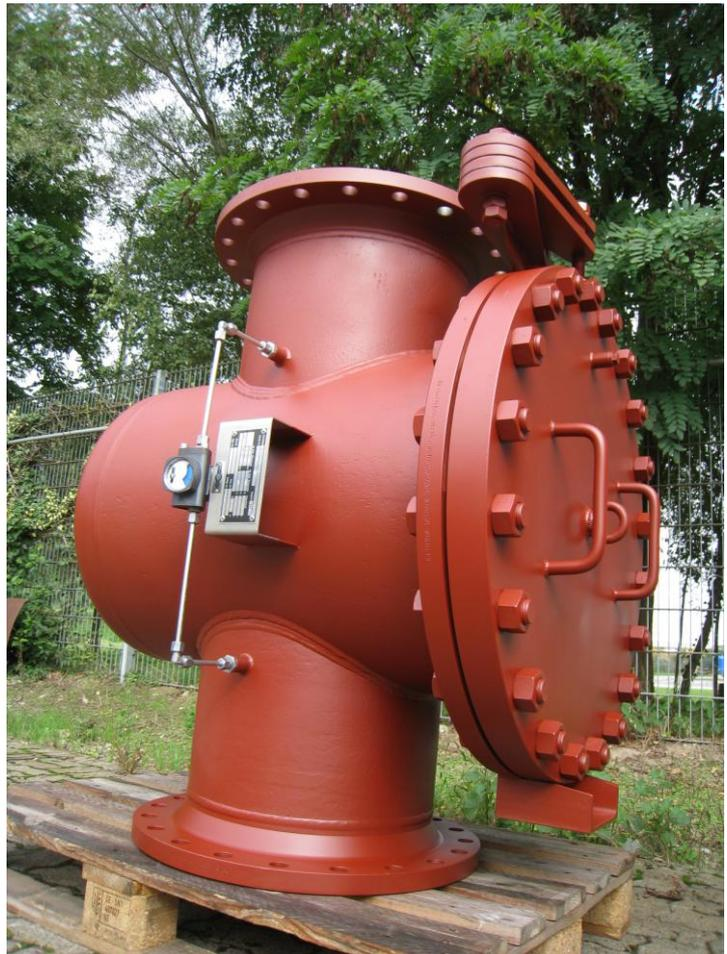
Fernwärmenetz in Graz sind die Filter in DN450 mit der Druckstufe PN 25 mit Einschweißenden (SS) im Einsatz.
